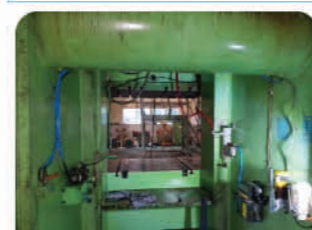
에어 배관 신규 설치 윤활 배관 신규 설치
