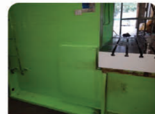
보강재 추가 용접 Crack 제거부 육성 용접
